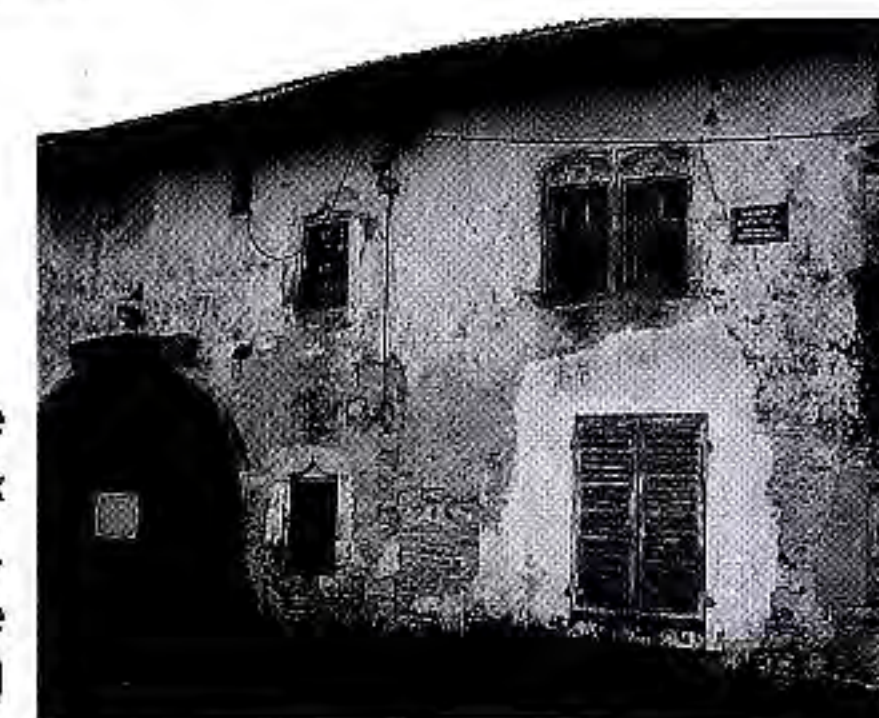
• Ferme à fenêtres d'angle (murées), à meneaux et linteaux trilobés au premier étage, à linteau en accolade à gauche Xaronval (canton de Charmes)
